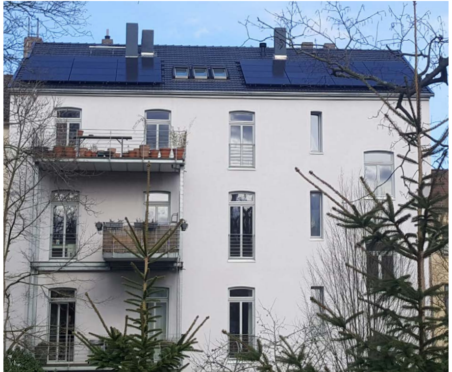
Friedrichstraße 20, Kriesten Architekt, 2019
