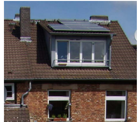
Kleinanlage auf Dachgaube 2004 Planungsgruppe Bau+Energie
