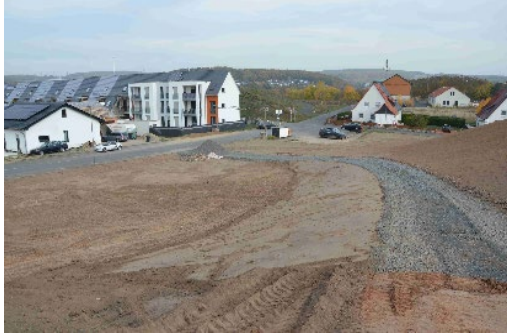
Vor dem Osterholz (VII/7b), im Bau, Blick vom Lärmschutzwall, 05.11.2018
