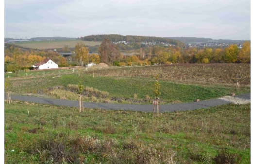
Vor dem Osterholz (VII/7b), Regenrückhaltebecken, 05.11.2018
