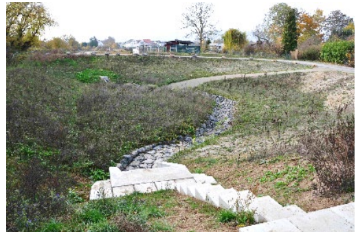
Zum Feldlager (IV/65), Regenrückhaltebecken, 05.11.2018
