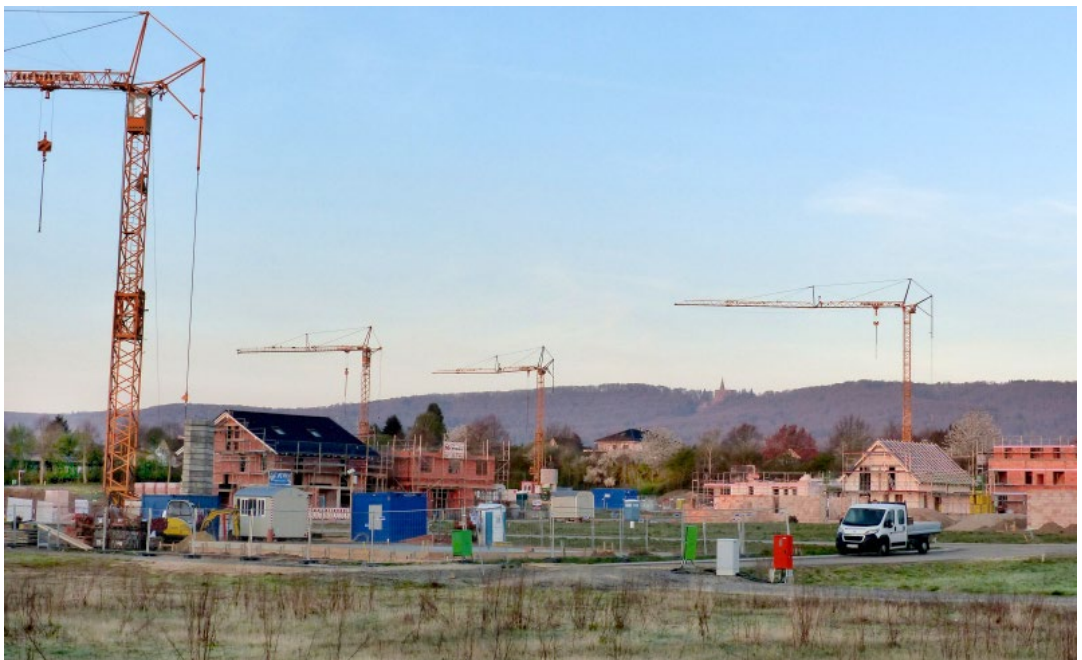
Zum Feldlager (IV/65), im Bau, 10.04.2020
