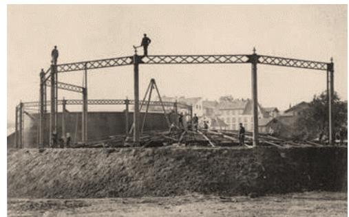
Neubau eines Gasspeichers im Jahr 1875 (Stadtarchiv Kassel, Foto: unbekannt)
