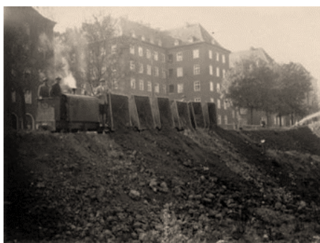
Loren am Rande der Herkulesstraße füllen die Baugrube auf (Stadtmuseum, Foto: Stier)
